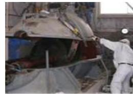
老朽化した排水ポンプ(分解点検)
