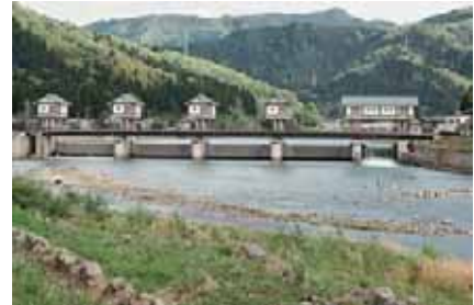
下流側から望む 足羽川頭首工
